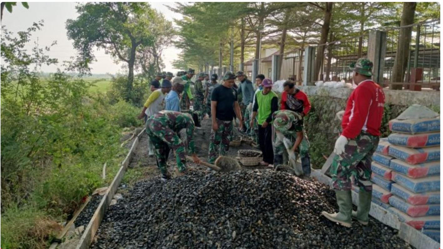
Foto istimewa ( Satgas tmmid reg 116 kebut pengecoran jalan
