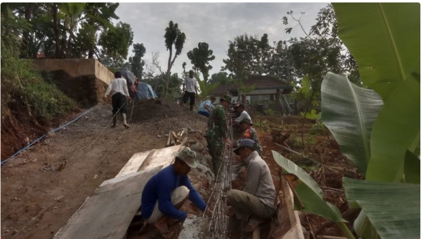
(Foto istimewa ) kegiatan pembuatan talud tmmd sengkuyung tahap II
